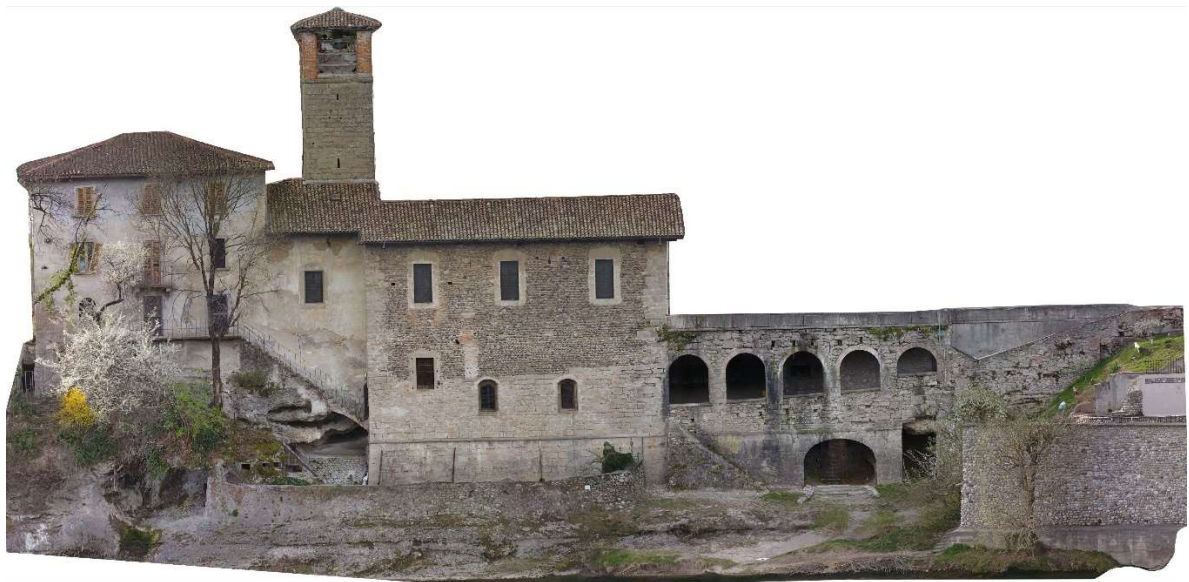
Fig. 5. Chiesa San Vittore. Elaborazione mediante sistema APR (Drone) e Laser-Scanner, Ecogeo srl, 03.05.2019
